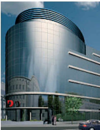
Espace Pétrusse, Luxembourg ARCHITECT: Marc Werner
